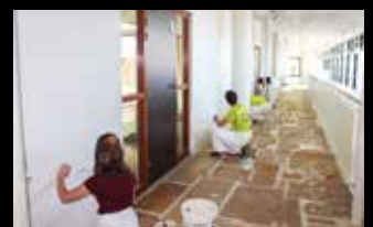
Chantiers trocs au palais des sports J.-C. Bouttier
