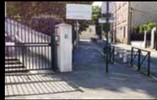
Aménagements sanitaires à l'école Carnot
