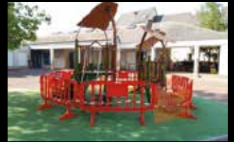
Aménagements sanitaires à l'école Anne Frank
