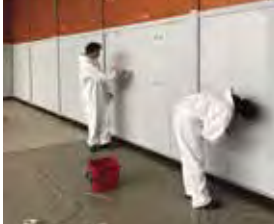
26-07 - Chantier troc au gymnase Gambetta
