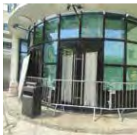
30-06 - Travaux de sécurisation de l'hôtel de ville après les émeutes
